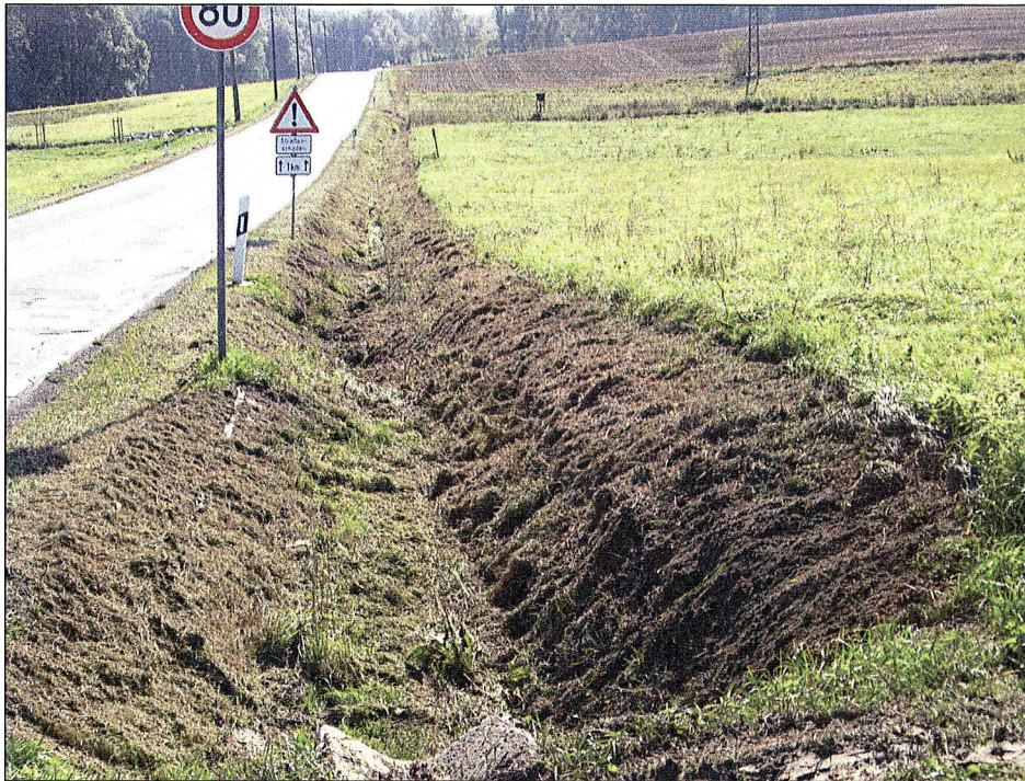
Bild 13: Deponie Grumbach, S 192 – Straße von Tharandt nach Grumbach, Blick nach Süden in die Talsenke mit dem Vorfluter „Gründchen“, Straßengraben auf Westseite, 09.10.2006
