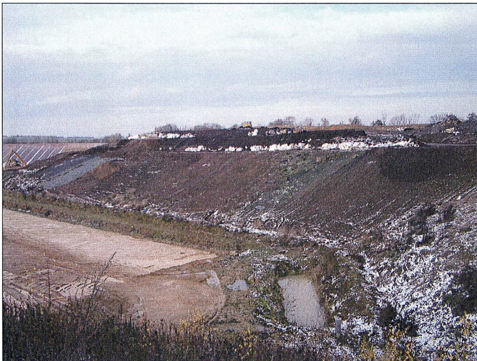
Bild 2: Deponie Grumbach, Blick vom SiWa-Pumpschacht nach Nord-Westen auf den Verfüllabschnitt 4 Teil 1, vorn die temporäre Oberflächenwasserefassung, 10.11.2004
