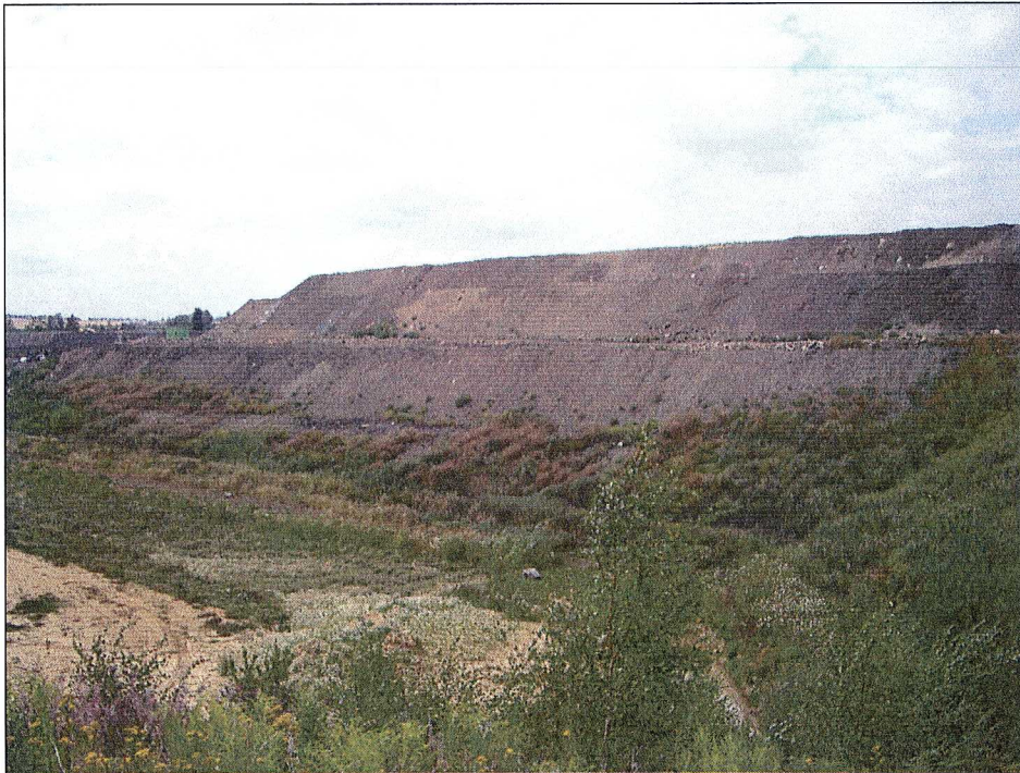
Bild 3: Deponie Grumbach, Blick vom SiWa-Pumpschacht nach Nord-Westen auf den Verfüllabschnitt 4 Teil 1, Höhe der Böschungsoberkante ca. 311 m HN, 02.08.2006
