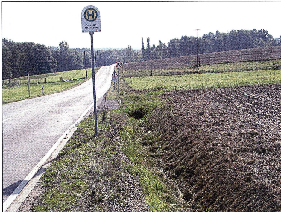
Bild 12: Deponie Grumbach, S 192 – Straße von Tharandt nach Grumbach, Blick nach Süden in die Talsenke mit dem Vorfluter „Gründchen“ und Straßendurchlaß, 09.10.2006
